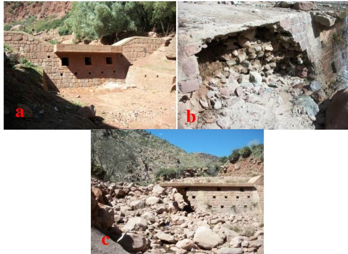
Figure 6 . a. Seuil en maçonnerie non endommagé; b. Seuil en maçonnerie moyennement endommagé ; c. Seuil en maçonnerie totalement endommagé
