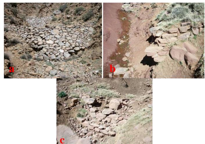
Figure 10. a , Seuil en pierres sèches non endommagé ; b , Seuil en pierres sèches totalement endommagé ; c . Seuil en pierres sèches moyennement endommagé
