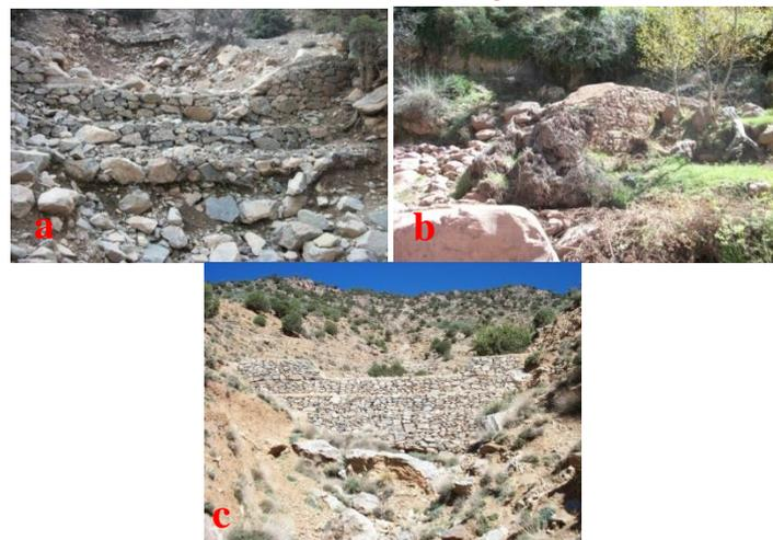
Figure 8. a . Seuil en gabions moyennement endommagé ; b , Seuil en gabions totalement endommagé ; c . Seuil en gabions non endommagé
